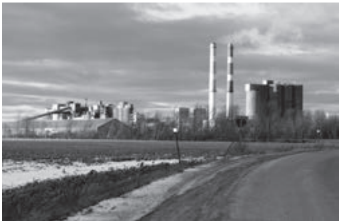
Une vue des cheminées de l'usine de Ciment Lafarge à Saint-Constant. Le défi est de réduire au maximum les émissions de CO 2 de nos usines ou de le capter afin de le réutiliser.
